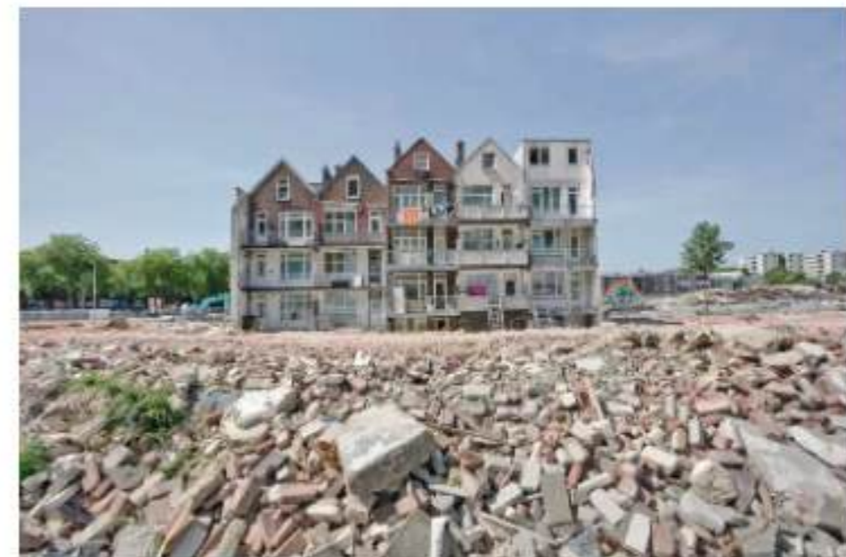
Sloopwerkzaamheden in de Tweebosbuurt te Rotterdam-Zuid. Beeld Otto Snoek
